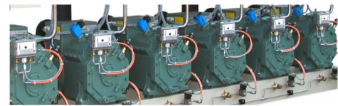
Kälteverbund mit Kompressoren von Bitzer
